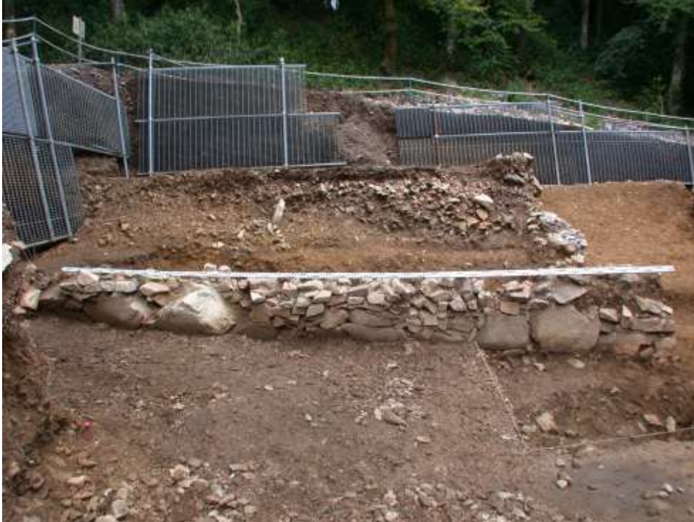
Abb. 2: La Poterne du Porrey, Linke Frontmauer mit einzelnen großen Blöcken und dazwischen bzw. darauf eingefügtem kleinerem Bruchsteinen (Foto: Th. Pertwieser, CAE/IUF).
